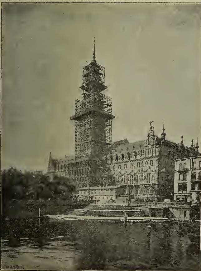
Ansicht i. J. 1894 vor Abrüstung des Thurmes.
